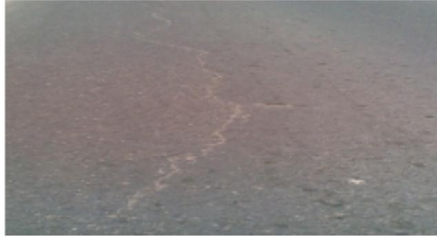
Gambar 2. 31 Retak Berkelok-Kelok (*Meandering Cracks*)
