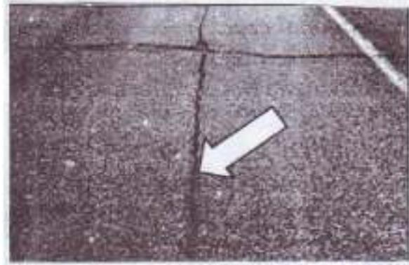
Gambar 2. 28 Retak Memanjang (*Longitudinal Cracks*)
