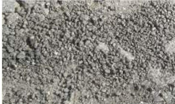
Gambar 2. 37 Kerusakan Pelapukan dan Pelepasan Butir (*Weathering and Raveling*)
