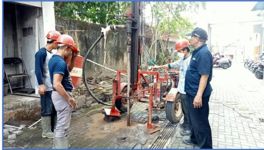
**Gambar 11.5:** Proses Pengeboran Sumur dengan Alat CTM 10.000
