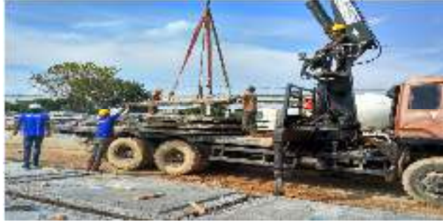
Gambar 2.3 Tahap Pengiriman Beton Precast
