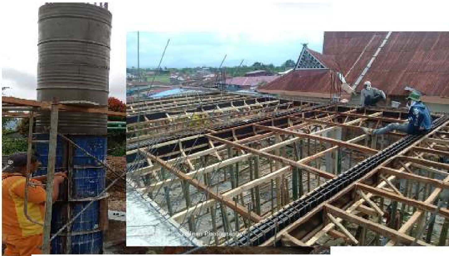
Gambar 3.12 Pekerjaan Plat Lantai 2 Pembangunan gedung Inkulturatif GBKP Bukit
