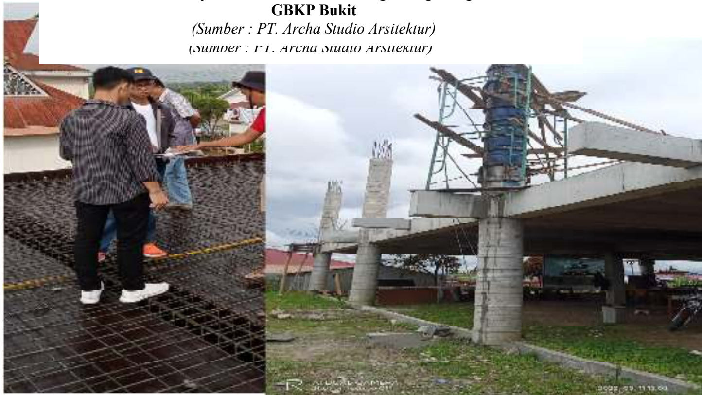
Gambar 3.11 Pekerjaan Balok Lantai 2 Pembangunan gedung Inkulturatif ? GBKP Bukit
