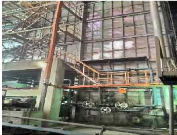
Gambar 3.8 Boiler pada PLTU Biomassa
