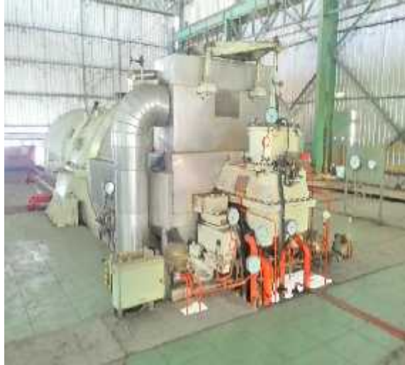
Gambar 3.10 Turbin Uap pada PLTU Biomassa
