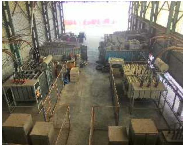
Gambar 3.14 Transformator pada PLTU Biomassa
