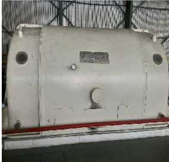
Gambar 3.11 Generator pada PLTU Biomassa
