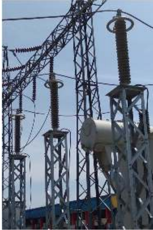
Gambar 3.9 Arrester ASEA Tipe XAR 170A3/144
