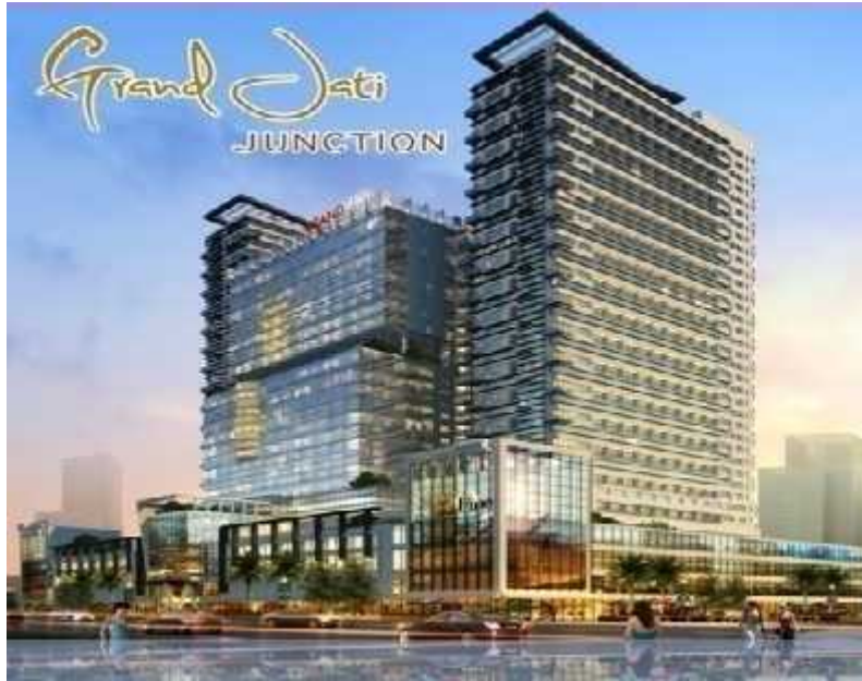
Gambar 3.1. Tampak depan proyek Apartemen Grand Jati Junction
