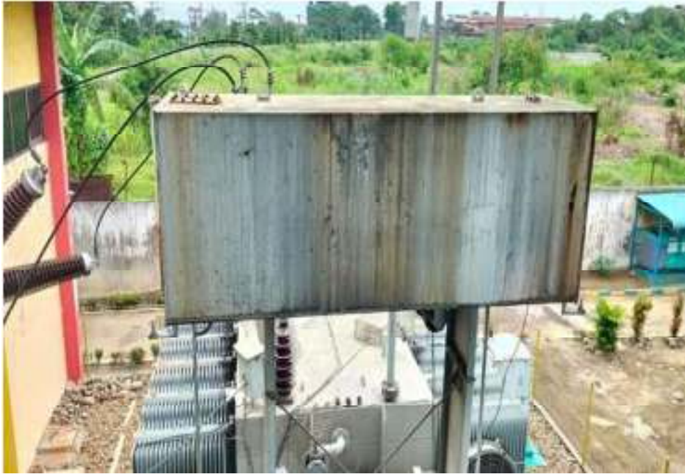
Gambar 3.4 Tanki Konservator TD GI Mabar
