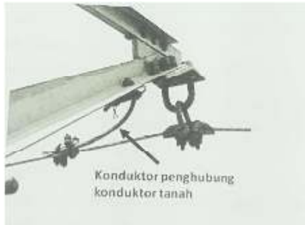
Gambar 2.9 konduktor penghubung konduktor tanah (b)
