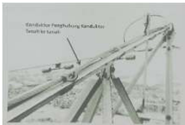
Gambar 2.9 konduktor penghubung konduktor tanah ke tanah (c)
