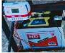
Gambar 3.27 Pemasangan Kabel dari SCC ke Terminal Baterai
