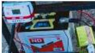
Gambar 3.28 Pemasangan Kabel dari Terminal Baterai ke Inverter
