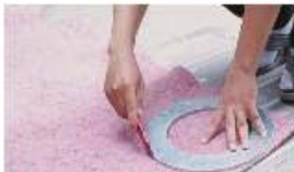
Gambar 3.20 Pemotongan *Glasswool*
