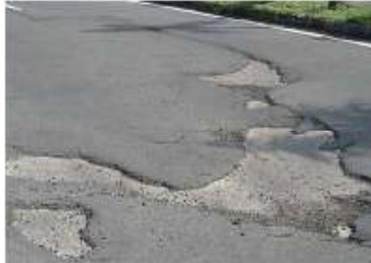
Gambar 2.14 Pengelupasan Lapisan Permukaan
