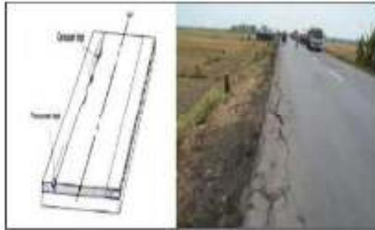
Gambar 2. 9 Cacat Tepi Jalan (*Edge Cracking*) (Sumber : *Manual Pemeliharaan Jalan No. 03/MN/B/1983*)
