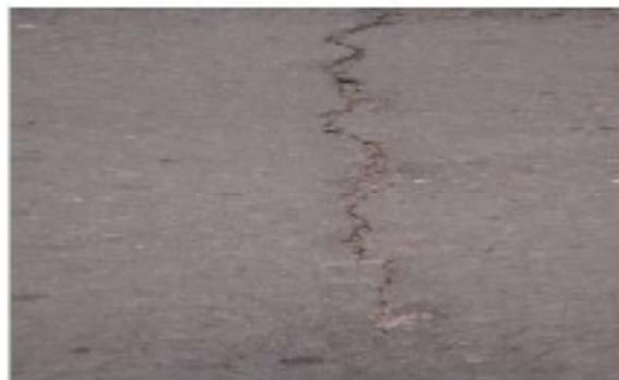
Gambar 2. 11 Retak Melintang (*Transverse Crack*) (Sumber : *Manual Pemeliharaan Jalan No. 03/MN/B/1983*)
