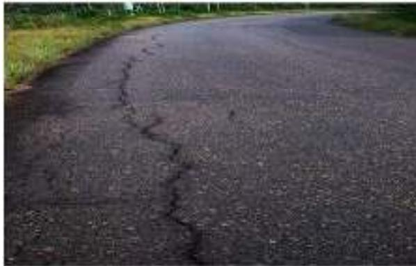
Gambar 2. 8 Retak Memanjang (*Longitudinal Cracks*)
