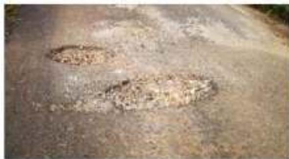
Gambar 2. 6 Lubang (*Pothole*)
