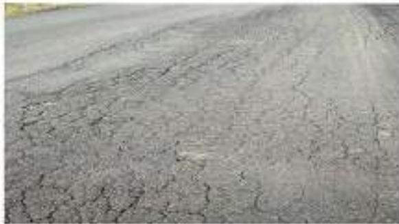
Gambar 2. 2 Retak Kulit Buaya (*Alligator Cracking*)
