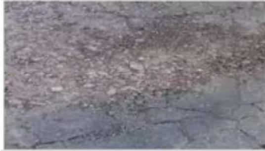
Gambar 2. 14 Pelepasan Butir (*Weathering/Raveling*)
