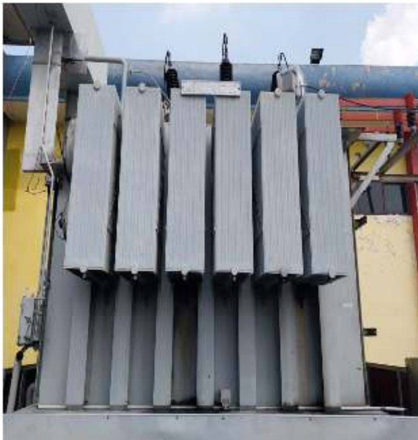
Gambar 2.5 Transformator daya.
