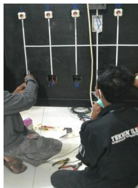
Gambar 2. Pemasangan saklar tunggal dan stop kontak dengan satu lampu
