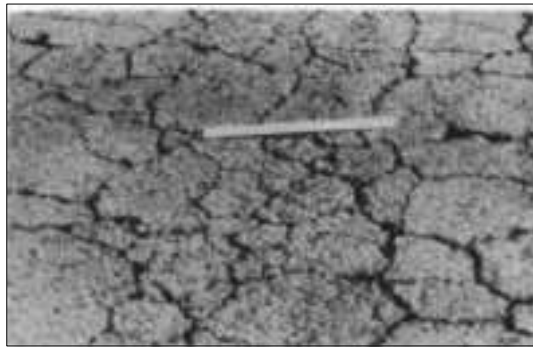
Gambar 2. 2 Retak kulit buaya
