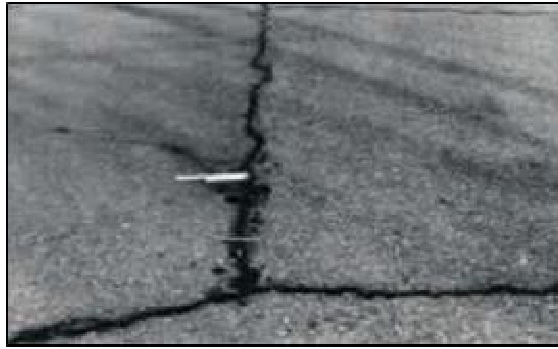
Gambar 2. 4 Retak sambungan
