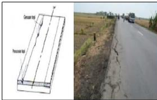
Gambar 2. 3 Retak pinggir
