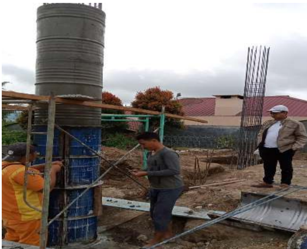
Gambar 3.7 Pekerjaan Kolom Pembangunan gedung Inkulturatif GBKP Bukit (Sumber : PT. Archa Studio Arsitektur)
