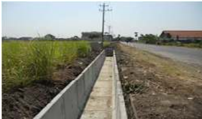
Gambar 2.7 Drainase Saluran Terbuka (Sumber : Google, 2022)
