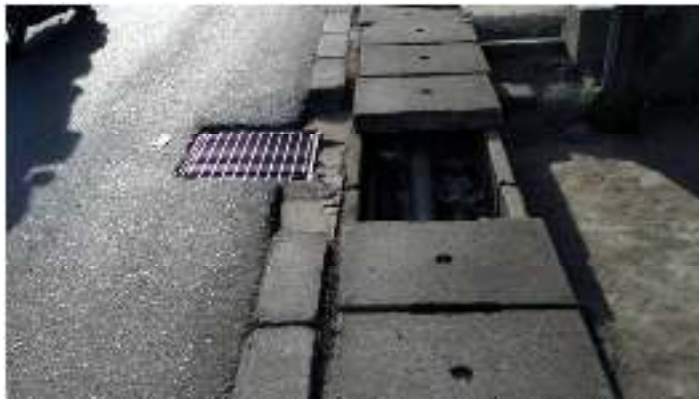
Gambar 2.3 Drainase Permukaan Tanah (Sumber : Google, 2022)
