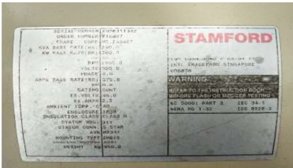
Gambar 3.2 Spesifikasi Generator Listrik Merk Stamford
