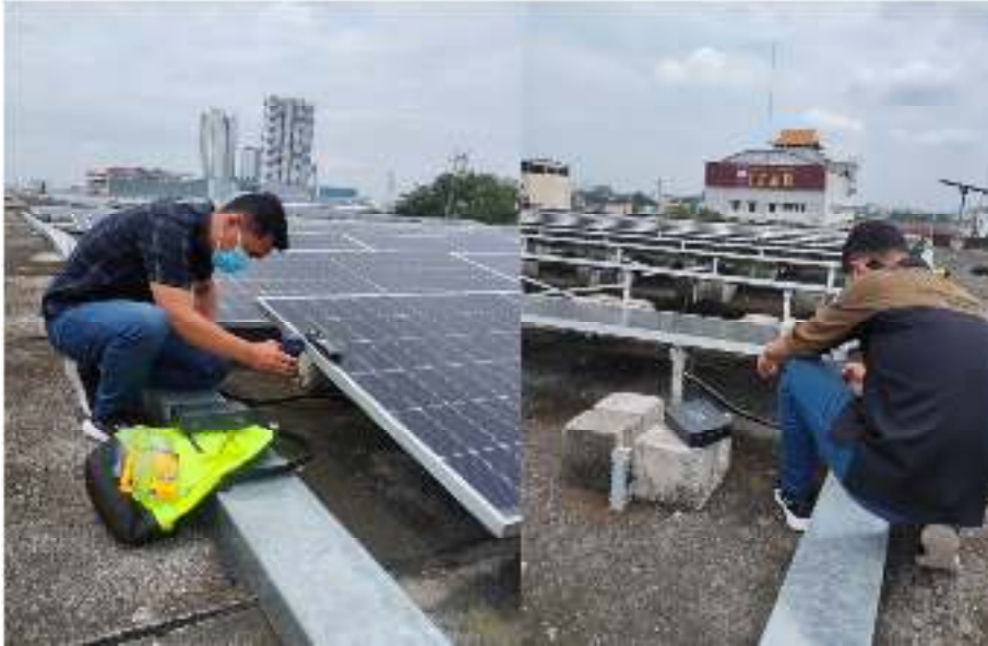
Gambar.3.1 Dokumentasi Saat Pengukuran Irradiance Dan Intensitas Cahaya
