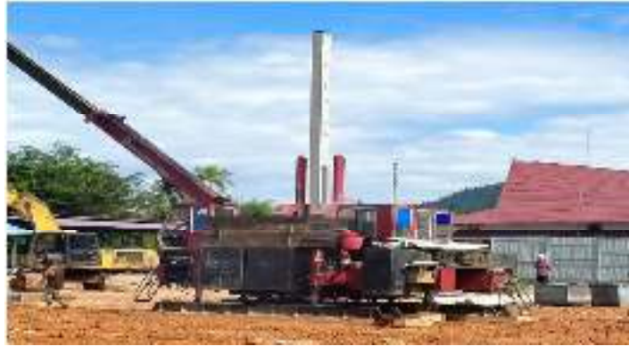
Gambar 2. 7 Alat pemancangan Hidraulic Static Pile Driver (HSPD)
