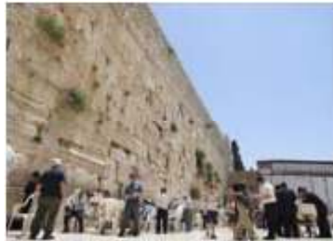
Gambar 2. 14 contoh bangunan dari masa lalu yang memakai dinding penahan tanah:(a)Tembok raksasa China; (b) Taman Gantung Babylonia; (c) Tembok barat Yerusalem
