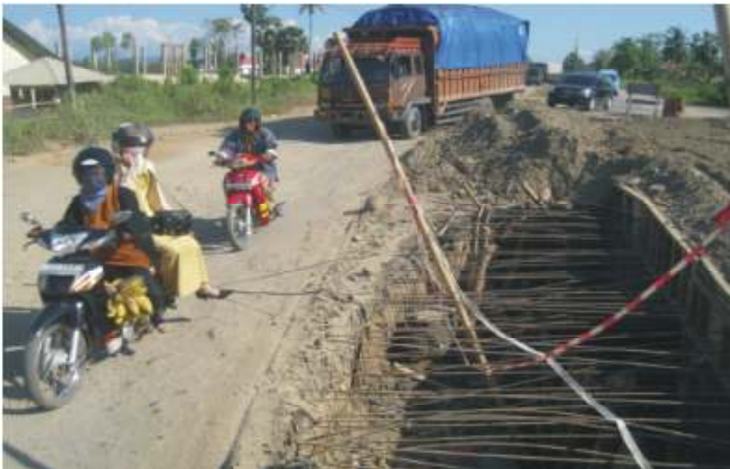
Gambar 2.6. Tidak terdapat deliniasi atau pagar keselamatan untuk memisahkan lokasi kerja dari lalu lintas. Seperti pada gambar 2.6.
