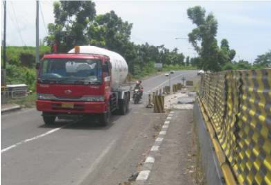
Gambar 2.8. Lebar lajur berkurang banyak, tetapi lalu lintas tidak diatur berkeselamatan melalui titik menyempit. seperti pada gambar 2.8
