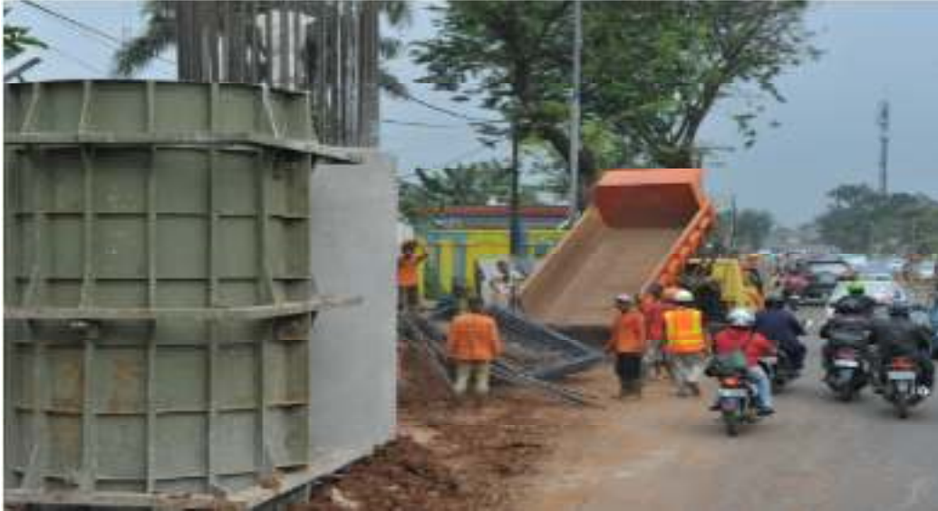
Gambar 2.6. Tidak terdapat deliniasi atau pagar keselamatan untuk memisahkan lokasi kerja dari lalu lintas. Seperti pada gambar 2.6.
